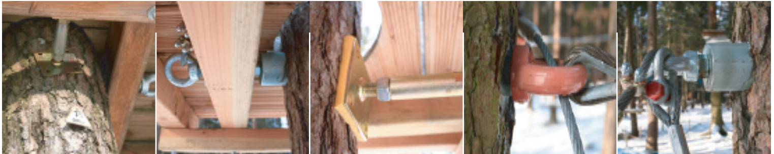
Alte Konstruktion der Plattform (am Einwachsen)
