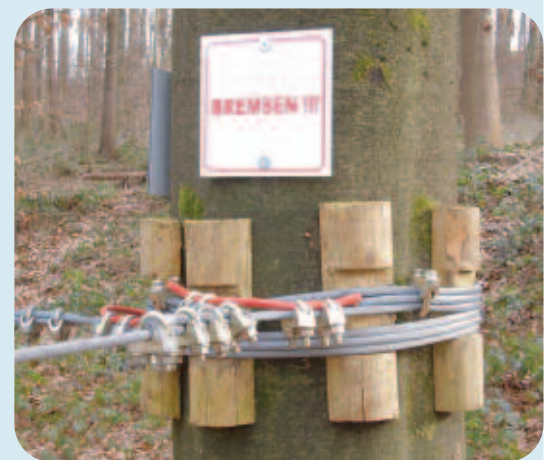
Ein Baum ist kein passives Bremssystem
