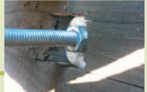
Faserriss im Tragbalken aufgrund des Dickenwachstums (nach 5 Jahren)
