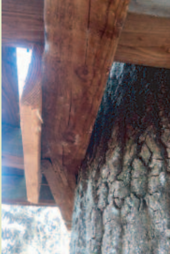
Bruch des Tragbalkens aufgrund des Dickenwachstums (nach 5 Jahren)
