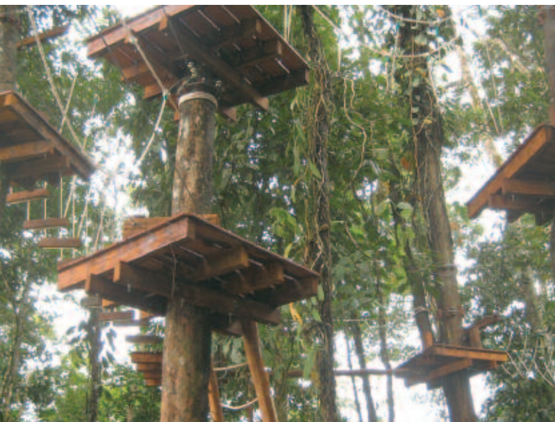
Der Waldseilpark im Regenwald entsteht
