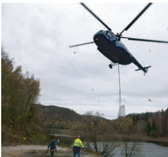
Ein Lastenhubschrauber unterstützt das Bauteam Foto: Harzdrenalin
