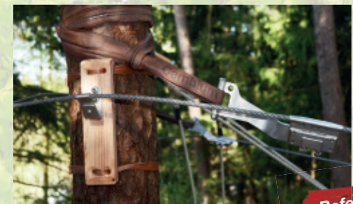
Seitenhalter mit Seilspanner optimale Integration in Cambium-Schlingen
