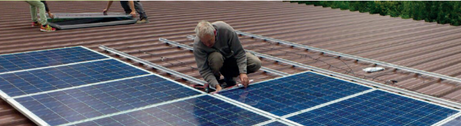
Die Photovoltaik-Anlage auf dem Dach wird montiert
