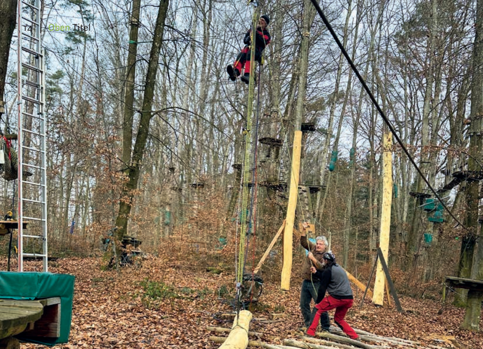
Im Abenteuerpark Immenstaad werden neue Rollen für die Seilrutschen installiert.
